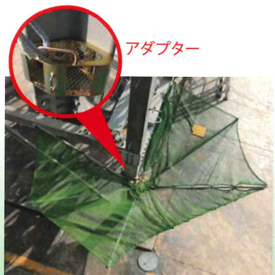
山形鋼鉄塔における取付状態
